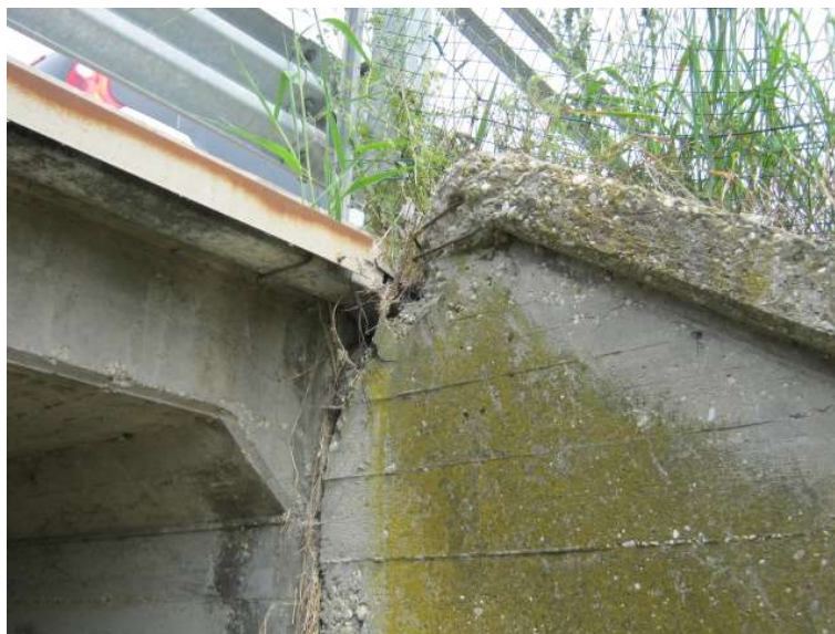
Ammaloramento muro d'ala
