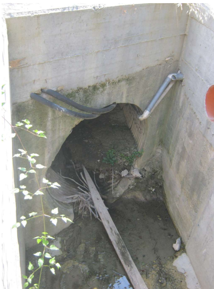
Presenza di detriti che riduce la funzionalità idraulica dell'opera
