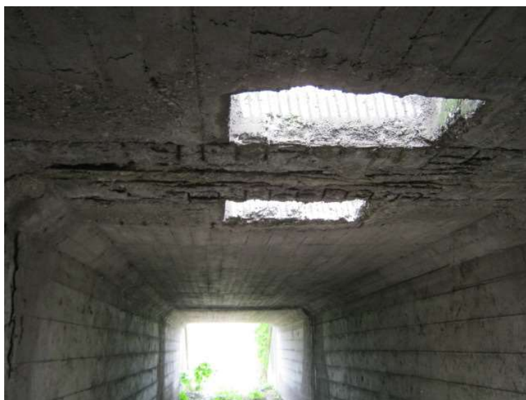
Ammaloramento giunto longitudinale
