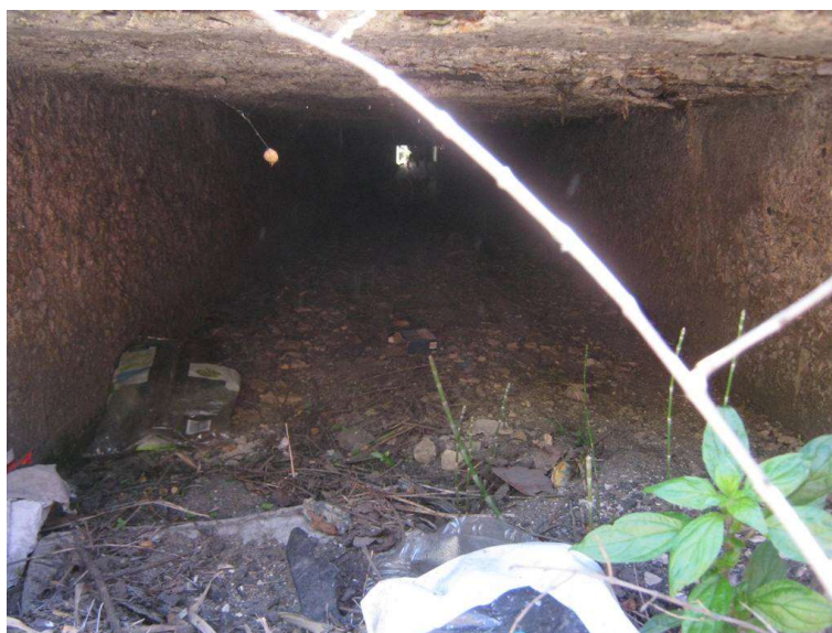
Presenza di detriti che riduce la funzionalità idraulica dell'opera
