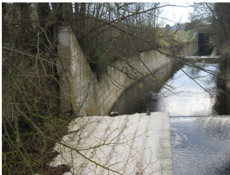
Cedimento del rivestimento di sponda
